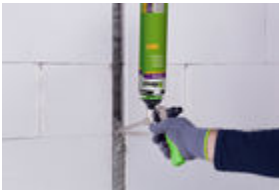
Verarbeitung mit FM190 in einer Brandschutzwand.
