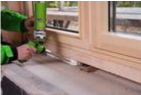
Verarbeitung des Fensteranschlusses mit FM230.
